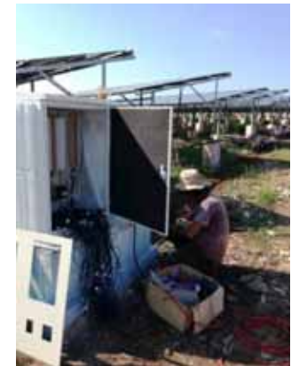
500kW solar smart grid
